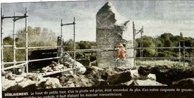
DÉBLAIEMENT. Le haut de petite tour, d'où la photo est prise, était encombré de plus d'un mètre cinquante de gravats. Avant de consolider les enduits, il faut d'abord les évacuer manuellement.
