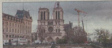
Le relevé effectué par Cédric Trentesaux et Rémi Fromont sert à la reconstruction de la charpente de Notre-Dame de Paris. (PHOTO : THIERRY LINDAUJER)
